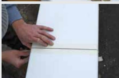
Sigillare le fughe con silicone acetico da esterno tra una barra e l'altra, silicone fornito da Coprimuro.net.
