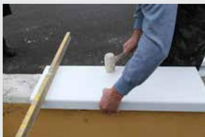
Importantissimo lasciare una fuga di 3mm per i prodotti chiari e di almeno 5mm per quelli scuri. La maggiore attenzione va data alle fughe che devono essere completamente pulite da residui di colle. Tra le fughe posizionare 4/5 mm di cilindro/corda in politilene o di caucciù.
