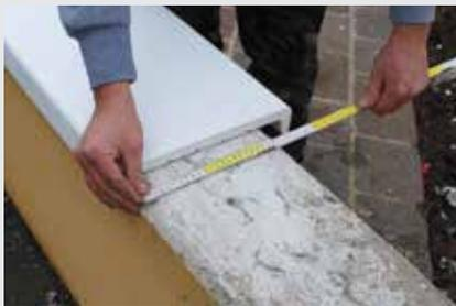
Assicurarsi che il coprimuro sia della misura compatibile, la misura va rilevata 1 cm sotto la superficie interna di appoggio.
