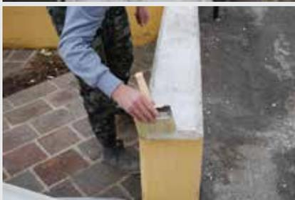
Pulire le barre ed il muretto da eventuali residui di polvere, eventualmente verificare se sul muro sia stato dato del distaccante in quel caso lavarlo con acqua calda e ancor meglio carteggiarlo.
